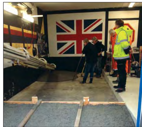
Avretting av golv i lokalet - alt på ett plan.
